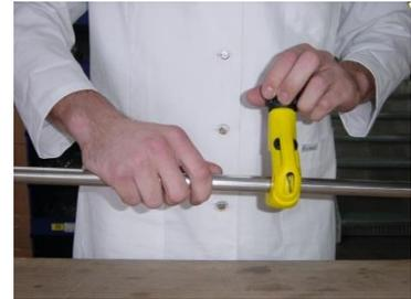
2. Entgraten Sie das Rohr sorgfältig innen und außen, da die Späne den O-Ring beschädigen und die Dichtheit beeinträchtigen können. Empfohlene Entgrater: REMS REG für Akku-Schrauber oder als Hand-Entgrater.
